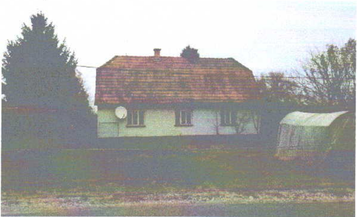
Pogled s cestne strani na stanovanjsko hišo
